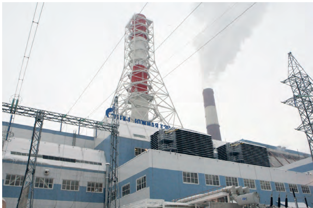
Новые ТЭЦ строятся, но доступ к мощностям по-прежнему затруднен.
