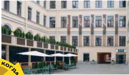
Торговый дом «Пассаж» в Петербурге.
